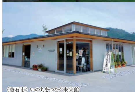
〈釜石市〉いのちをつなぐ未来館
