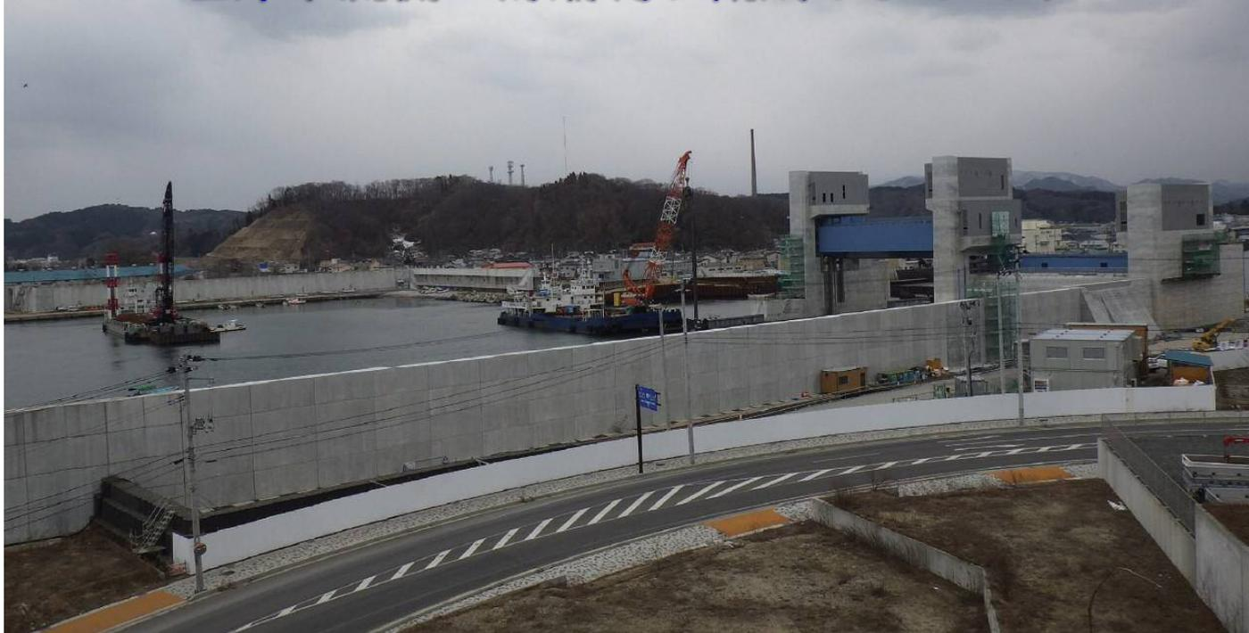
左岸（光岸地地区）側で水門下流に整備を進めていた防潮堤が概成しました。今回整備した防潮堤は近隣で完成済みの防潮堤と同じくT.P.+10.4mの高さとなります。今後、防潮堤のコンクリートブロックの隙間に目地材を注入して完成となります。
