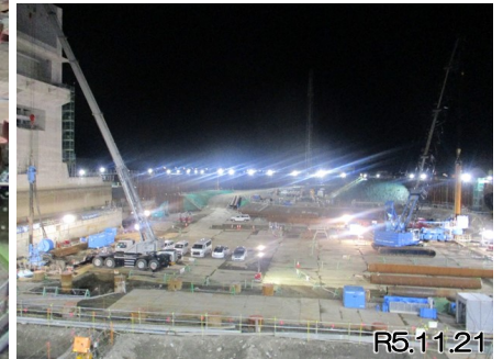
▲夜間施工の状況
