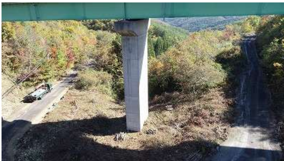
○工事着手前(P1 橋脚巻立工)
