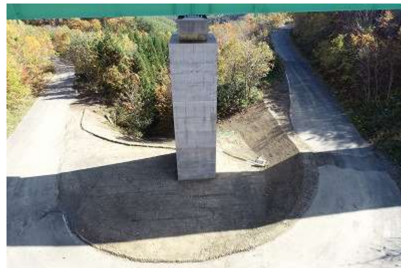
○工事完成(P1 橋脚巻立工)
