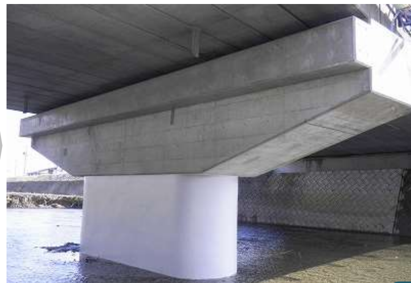
○工事完成(P1 沓座拡幅工)
