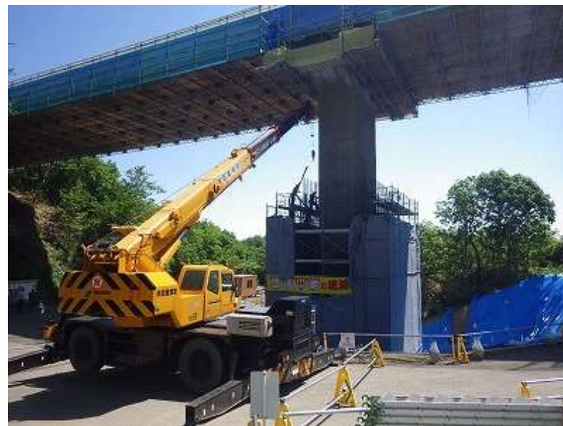
○工事完成(P1 橋脚巻立工)
