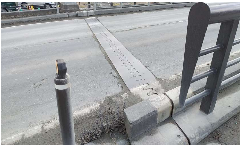
○工事着手前(伸縮装置交換工)
