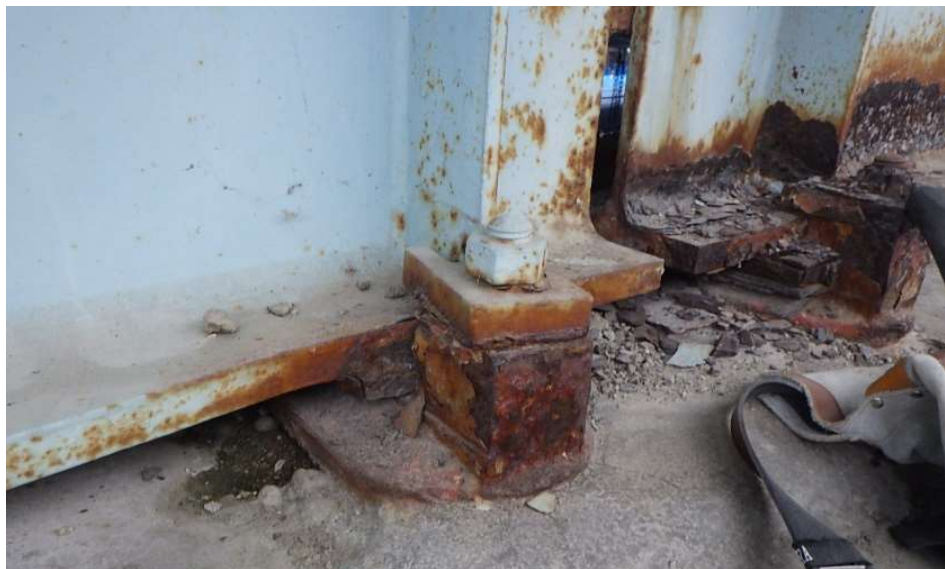
○工事着手前(P8支承補修工)
