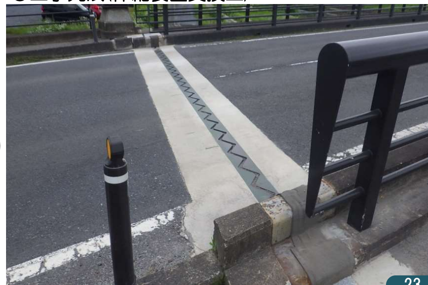
○工事完成(伸縮装置交換工)
