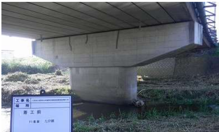
○工事着手前(P1 沓座拡幅工)
