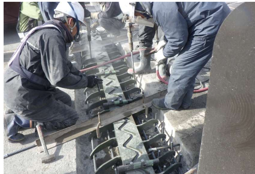
○工事完成(伸縮装置交換工)
