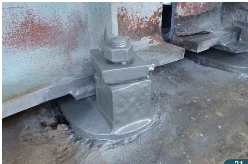
○工事完成(P8支承補修工)
