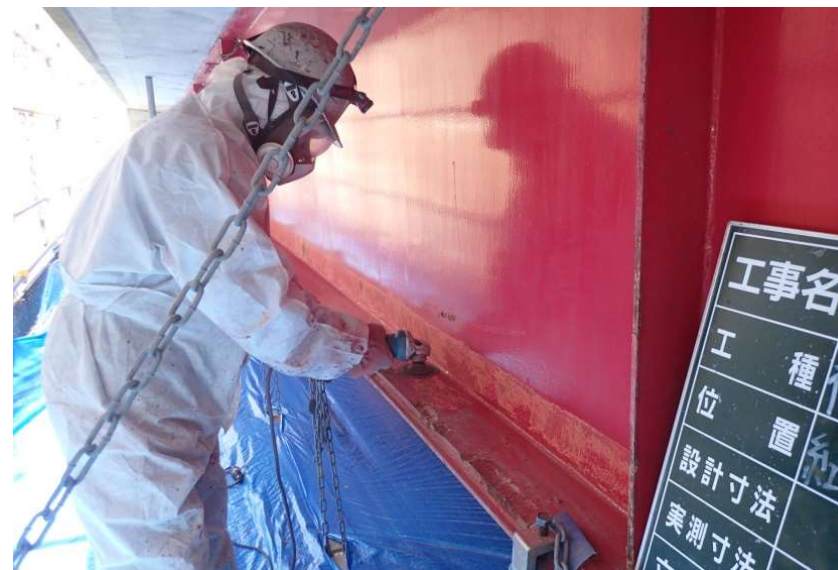
○工事完成(塗装塗替工)
