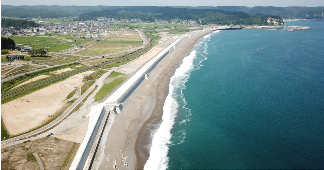
【野田村前浜地区の復旧状況 (H30. 8 撮影)】
