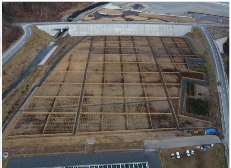
【田野畑村明戸地区防災林造成工事完成】 (着手 H28. 10~完成 H31. 1)
