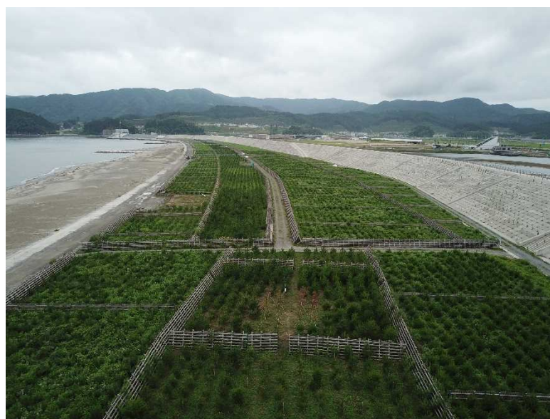
【高田松原防災林造成工事（実施中）】（R2.7.30撮影）
