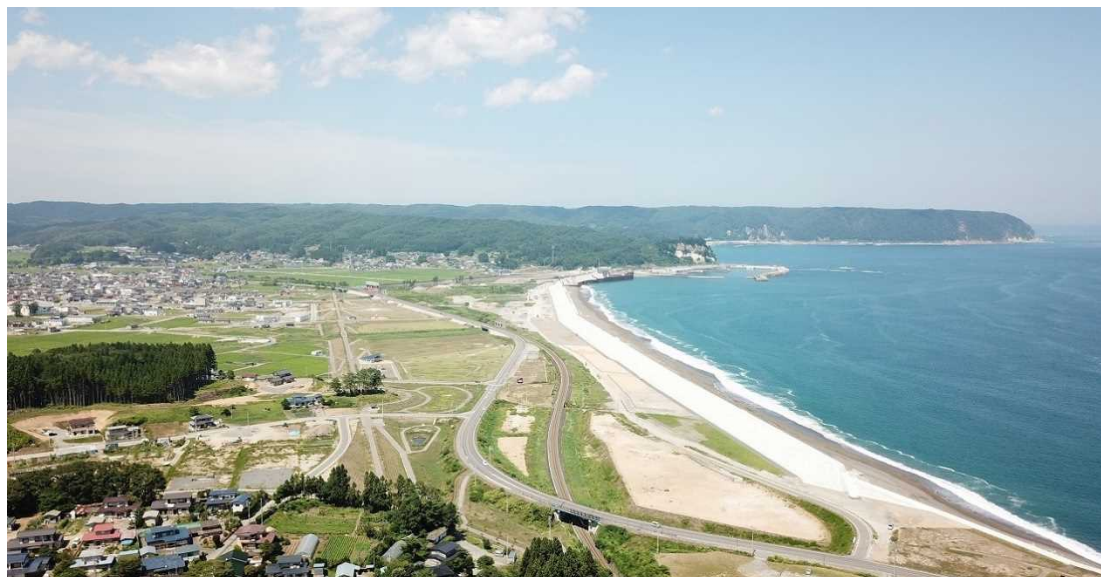
【野田村前浜地区の防潮堤（H30.6完成）】
