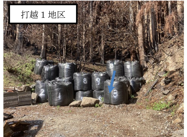
大型土のう設置後
