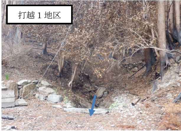
大型土のう設置前
