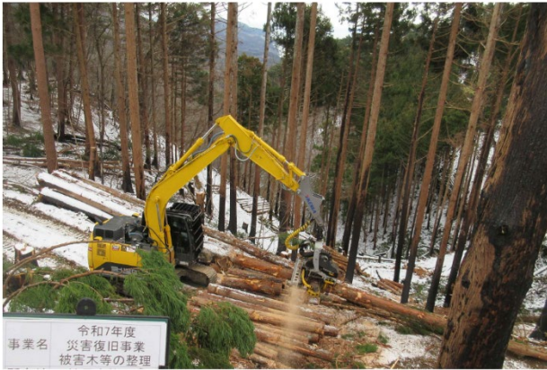
写真1 被災木の伐採状況
