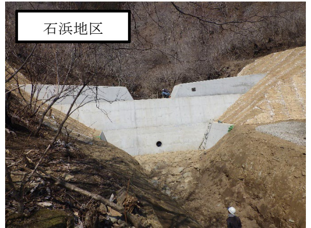
治山ダム整備後
