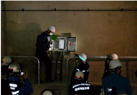
▲非常用電話の動作確認
