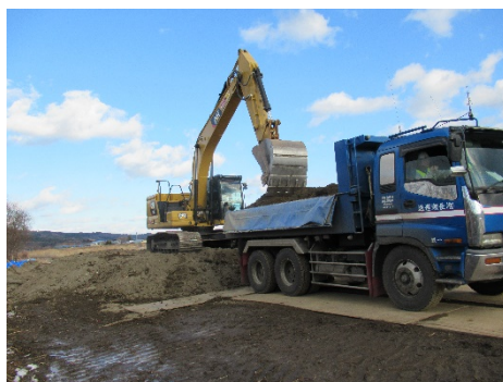
▲ペイロード機能を用いた積込作業
