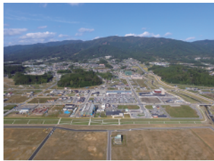
かさ上げ工事後の陸前高田市街地
