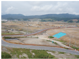
かさ上げ工事の様子
