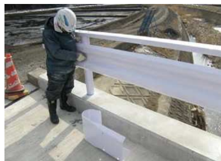
施工状況 (H24.3)
