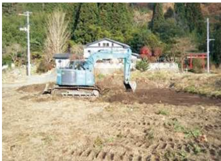
施工状況 (H23.11)
