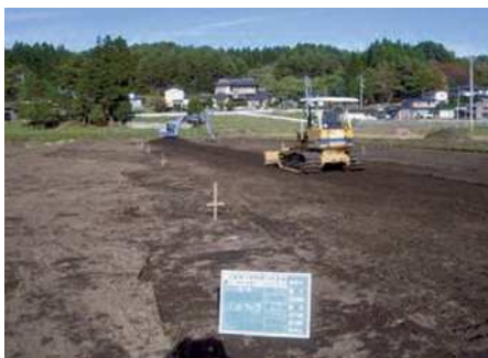
施工状況 (H23)
