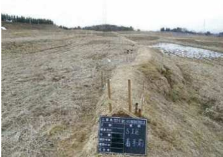
畦畔の移動と崩落
