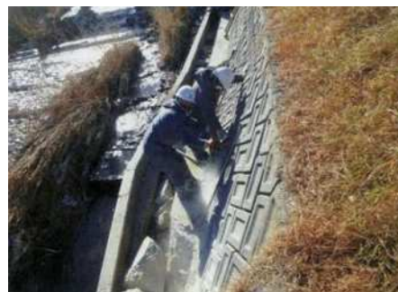
施工状況 (水路取り壊し)
