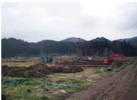
施工状況 (H23.6)
