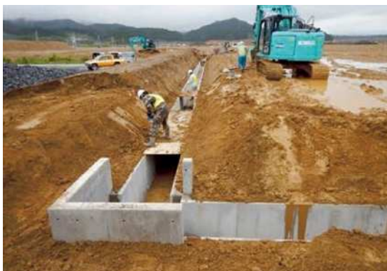
水路設置状況
