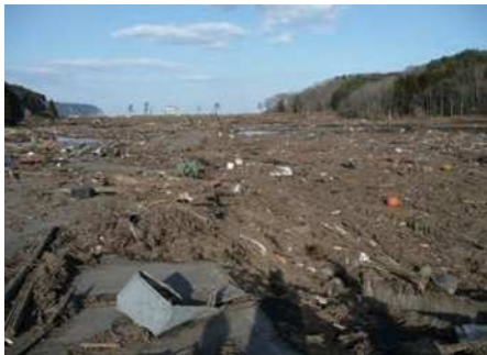
被災状況 (H23.3)
