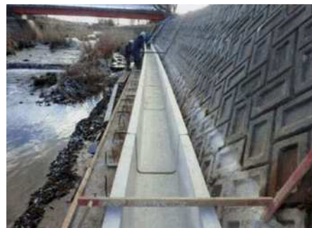
施工状況 (水路設置)
