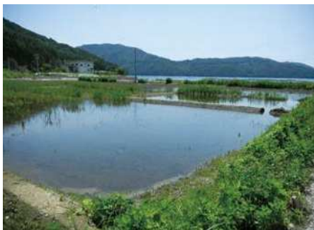
被災状況 (H23.3)
