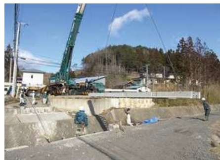
施工状況 (H24.2)
