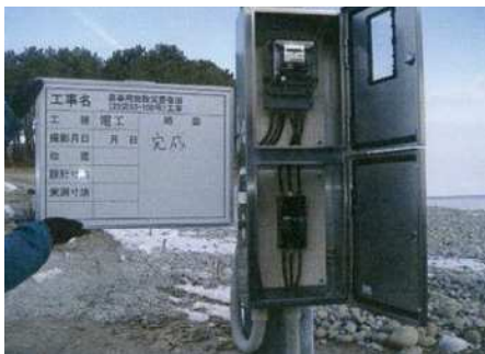
施工状況 (引込開閉器盤設置)
