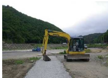
施工状況 (H23.10)
