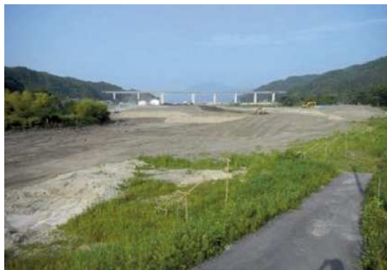
基盤整地状況
