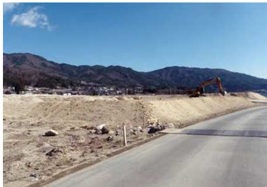
基盤整地状況
