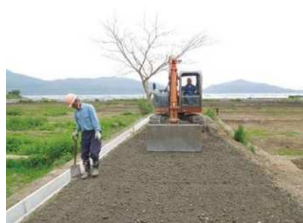
施工状況 (H24.5)
