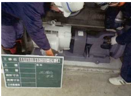
施工状況 (揚水ポンプ据付)
