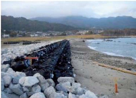
吉浜堤防応急工事（大船渡市）
