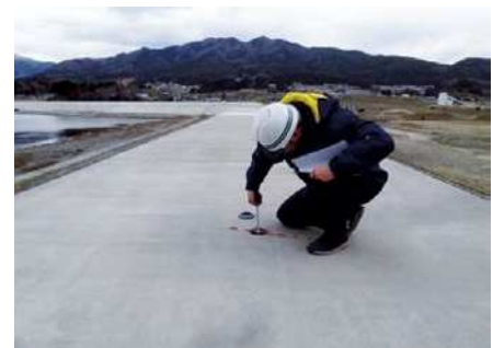
沈下量計測（小友海岸堤防）
