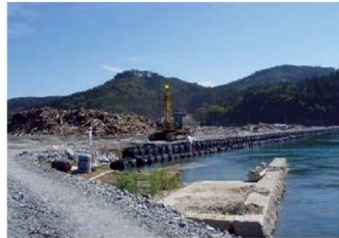
小友堤防応急工事（陸前高田市）
