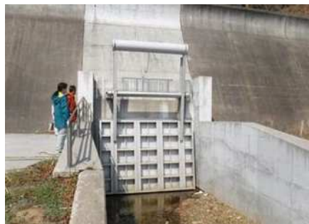
水門点検（宮古大沢海岸堤防）
