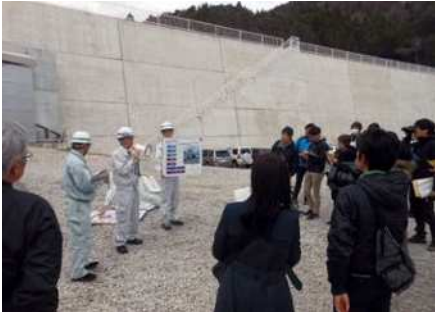
自動閉鎖システム概要説明(合足海岸堤防)
