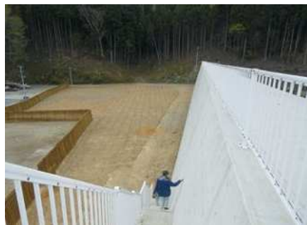
ひび割れ等目視点検（合足海岸堤防）
