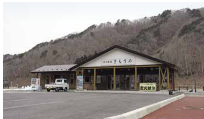
普代浜園地「きらうみ」の再整備及び海産物直売施設の整備（村）
