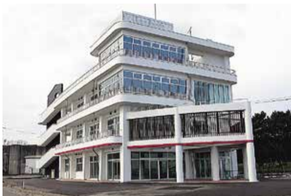
ひろの水産会館「ウニーク」の整備（津波で被災した旧物産館を水産会館として再建）（町）
