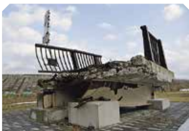
米田歩道橋の一部
