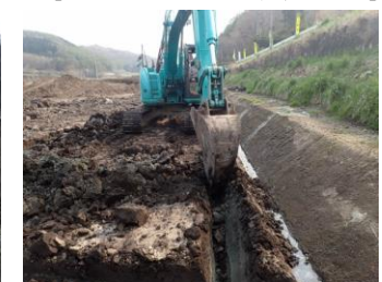
【簡易な基盤整備（暗渠排水）】
