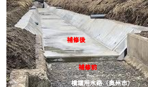
【補修による水路の長寿命化】
