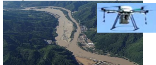
【ドローンによる被害調査イメージ】
