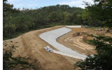
【ため池の対策工事状況】
