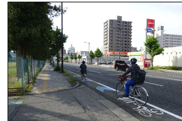
施工後の供用状況(主)盛岡横手線
