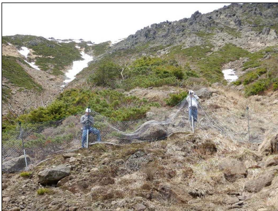
消雪直後の植生保護柵のネット張り作業(5/26)
