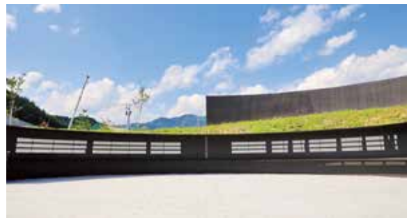
釜石祈りのパーク (東日本大震災犠牲者慰霊追悼施設)
