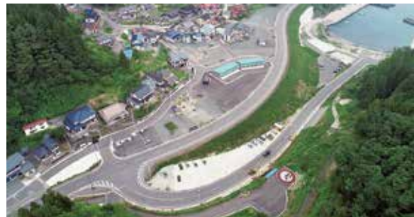
道路の高上げ工事が完了した羅賀地区
