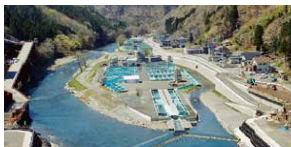
漁業集落防災機能強化事業（下安家地区）
