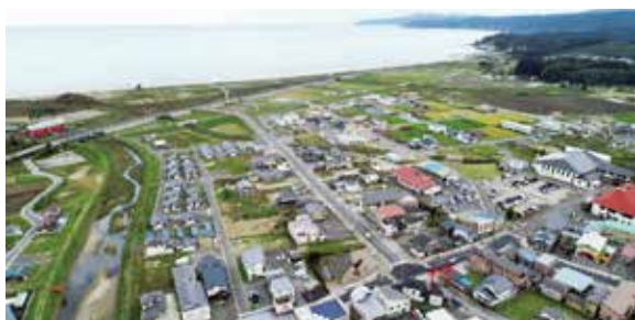
津波復興土地区画整理事業により整備した街並み
