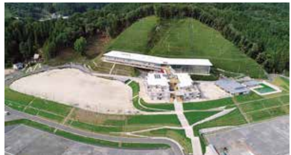
鵜住居小学校・釜石東中学校
