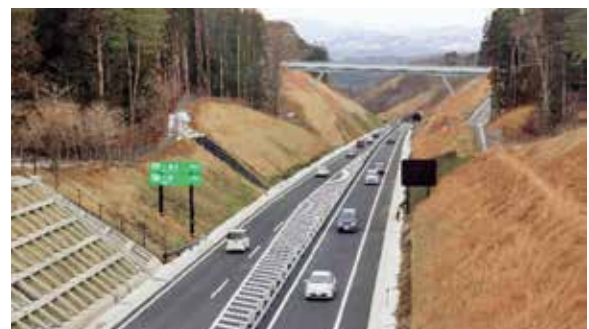
三陸沿岸道路久慈北道路
