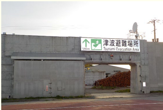
避難誘導標識の例 (藤原地域)
