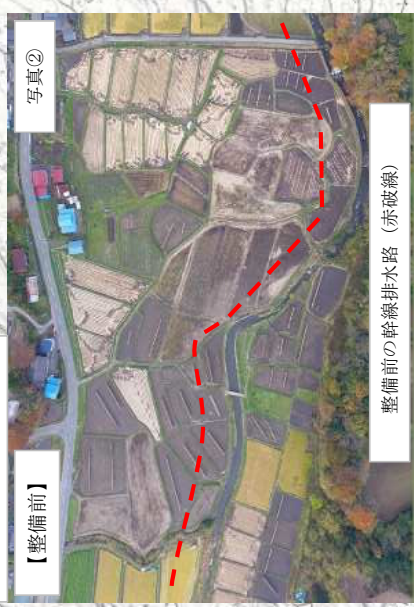
【幹線排水路の状況】
