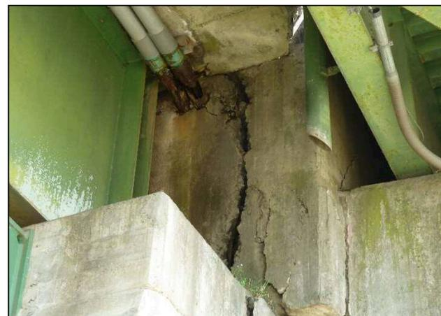
▲東日本大震災による損傷(橋台)
