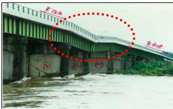
▲増水により橋脚が陥没
