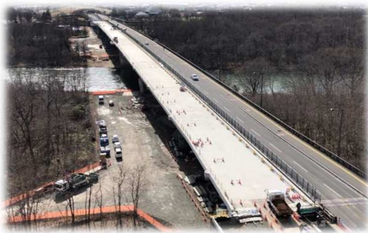
盛岡駅本宮線 杜の大橋 (建設中) (盛岡市)
