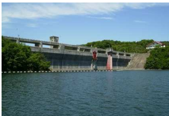
湖面から堤体を望む
