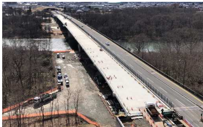
【都市計画道路盛岡駅本宮線】 盛岡市 杜の大橋 (撮影: 令和6年2月)
