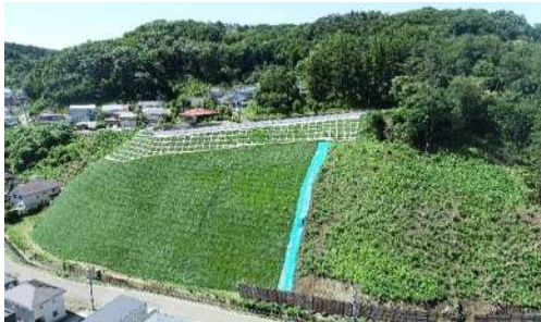
桜山地区急傾斜地崩壊対策（盛岡市） （撮影：令和5年6月）
