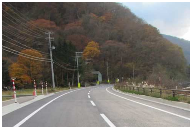
【一般国道282号】 八幡平市佐比内地区 (撮影: 令和5年11月)
