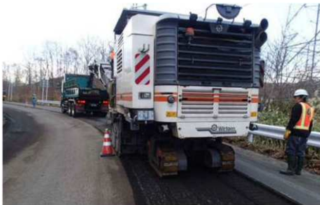
道路舗装の補修
