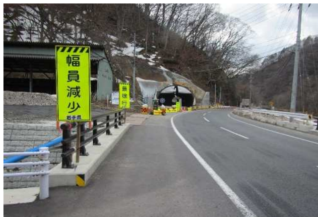
【一般国道282号】 八幡平市佐比内地区 （撮影：令和7年4月）
