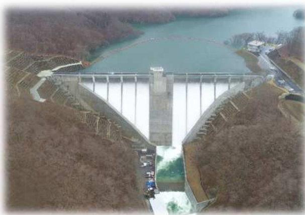
築川ダム（盛岡市）
