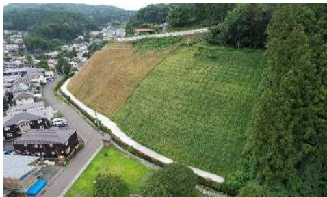
桜山地区急傾斜地崩壊対策（盛岡市） （撮影：令和6年8月）
