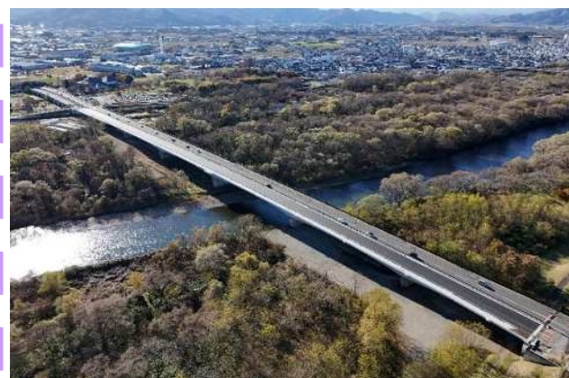
【都市計画道路盛岡駅本宮線】 盛岡市 杜の大橋 （撮影：令和6年11月）
