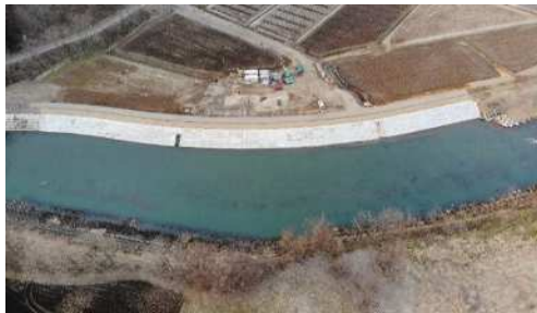
一級河川松川（盛岡市）（撮影：令和6年3月）
