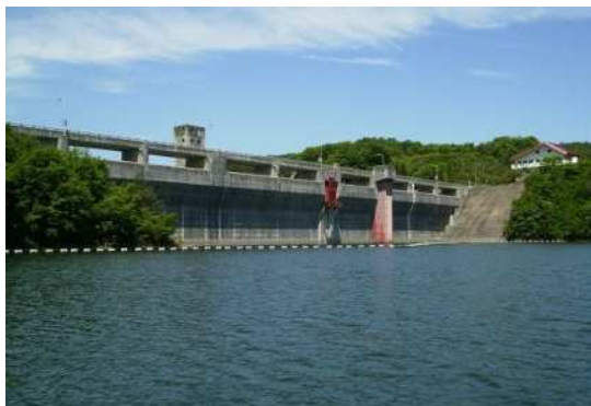
湖面から堤体を望む
