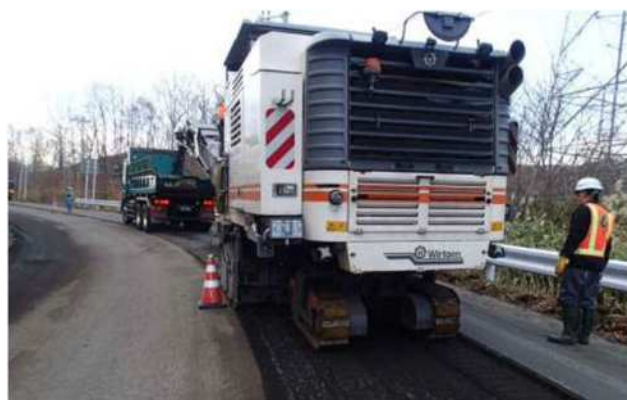
道路舗装の補修
