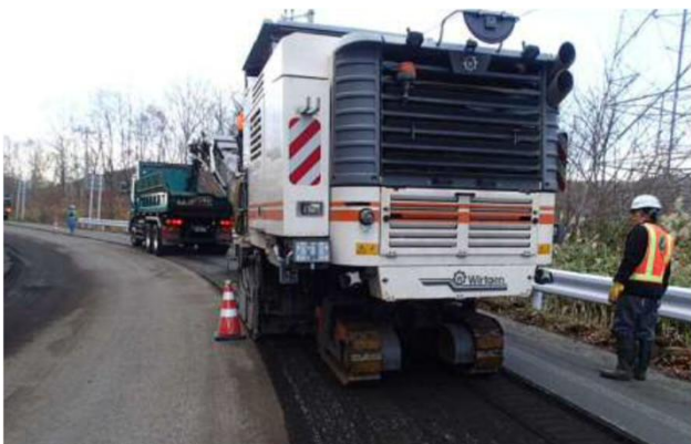
道路舗装の補修
