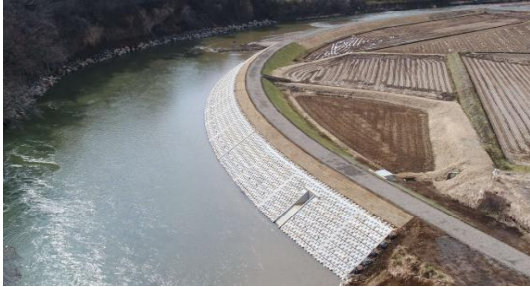
一級河川松川(盛岡市) (撮影: 令和8年3月)
