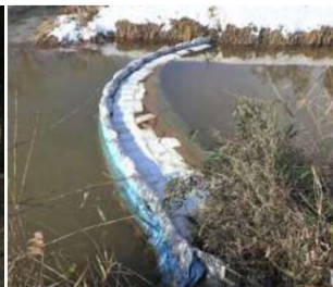
油流出事故の回収作業
