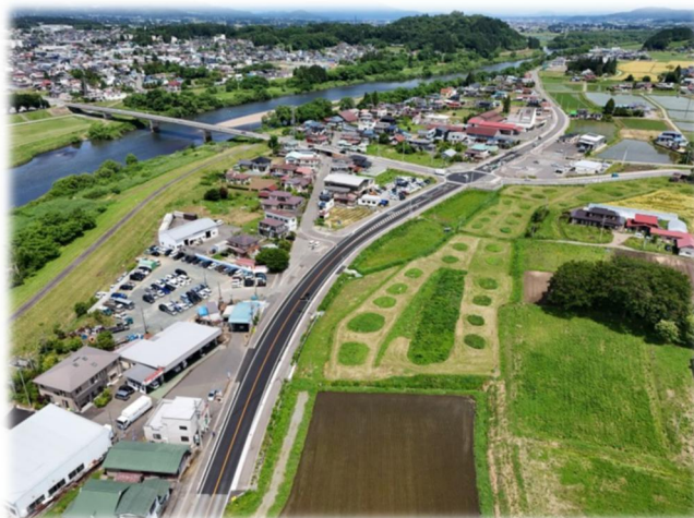
主要地方道紫波江繋線 星山地区 (紫波町)
