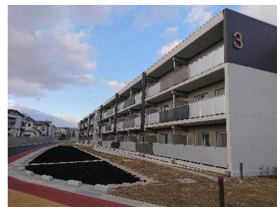
県営 南青山アパート 住戸のほか、支援センターや集会所など、入居者の見守りや交流の拠点となる環境の提供に努めています。
