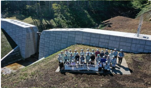
上鶴飼の沢砂防堰堤(滝沢市) (撮影: 令和7年9月)
