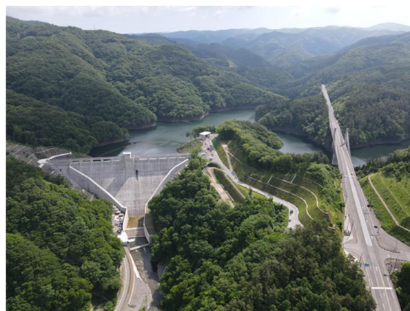
築川ダム全景（撮影：令和3年6月）
