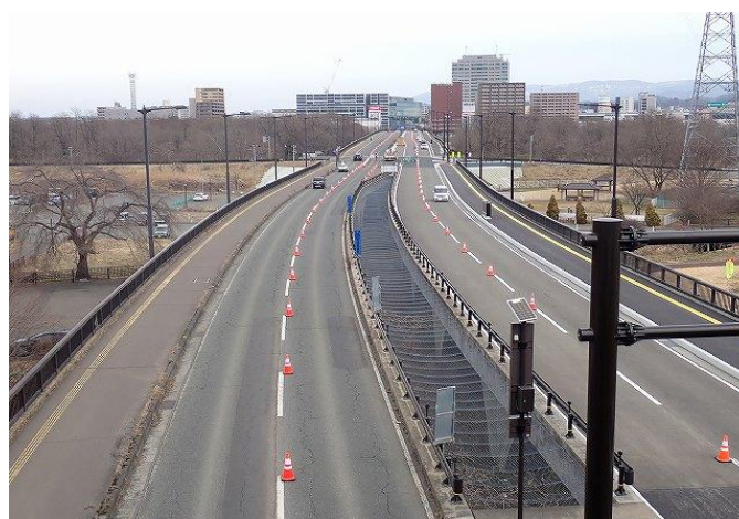
Ⅱ期線暫定供用（令和8年3月撮影）
