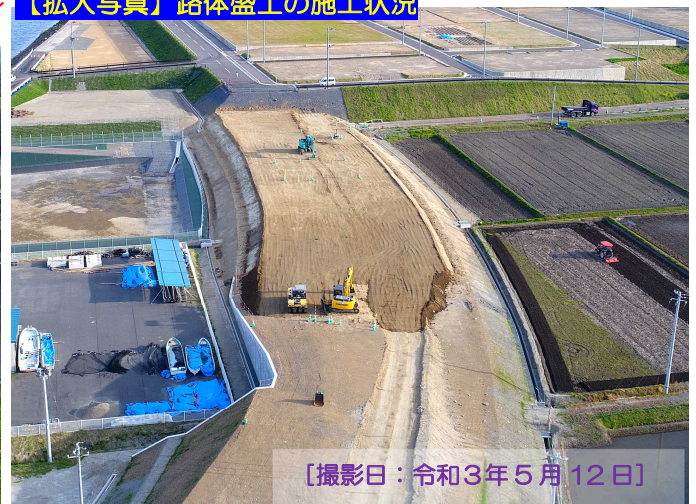
【拡大写真】路体盛土の施工状況
