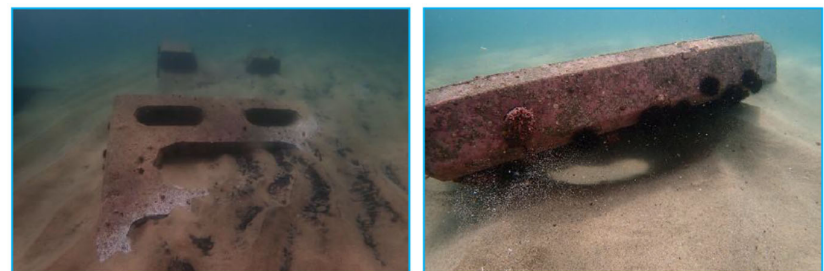
図 2-31 砂で埋没した増殖ブロック (普代村)
