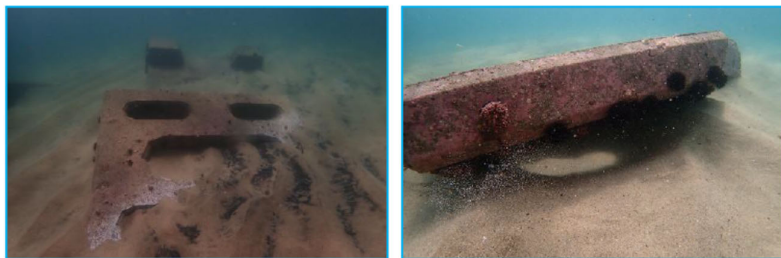
図 2-35 砂で埋没した増殖ブロック (普代村)
