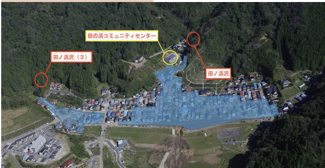
土砂の流出状況
