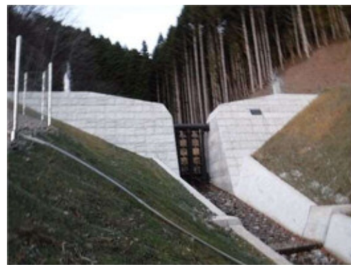
砂防堰堤完成事例
