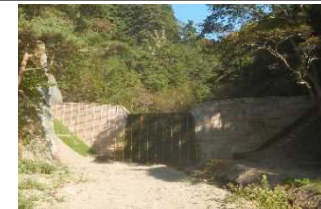
【治山：渓間工(久慈市)】
