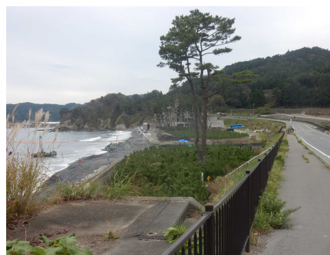
浪板地区 復旧後
