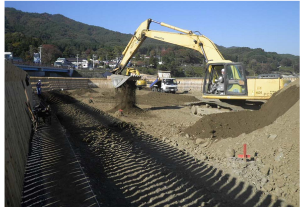
写真－1 植栽面の耕起（スケルトンバケットによる石礫除去）
