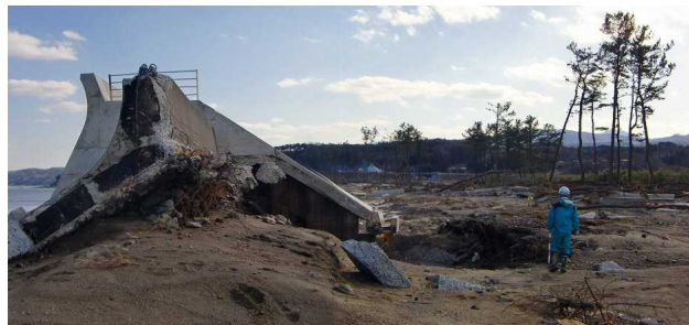
津波で破壊された前浜地区海岸防災林と防潮堤
