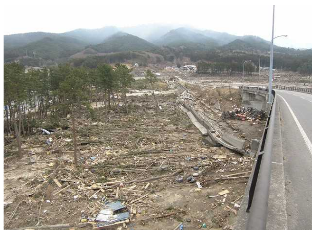
浦の浜地区防潮堤、海岸防災林（山田町）
