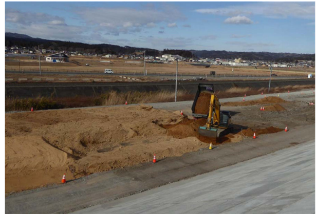
写真－2 締固めない盛土（バックホウ後退施工（重機上載最少施工））
