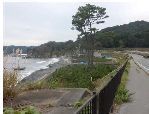
浪板地区 復旧後
