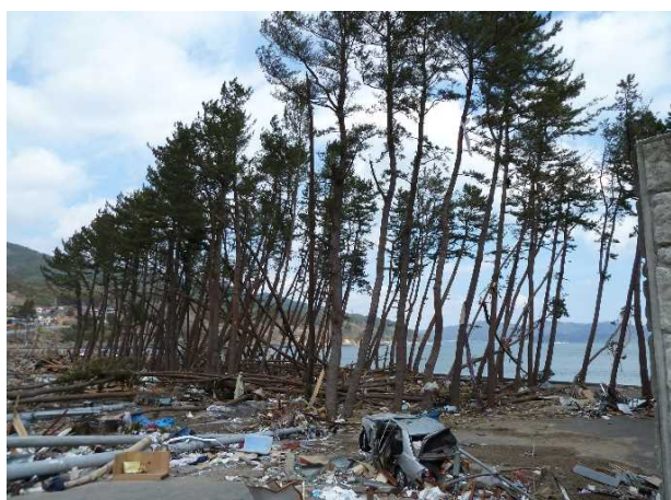
浪板地区防潮堤、海岸防災林（大槌町）
