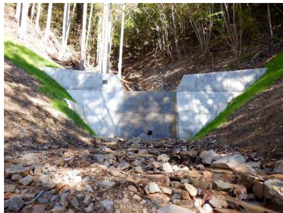
令和2年度完成 女遊戸地区 治山ダム
