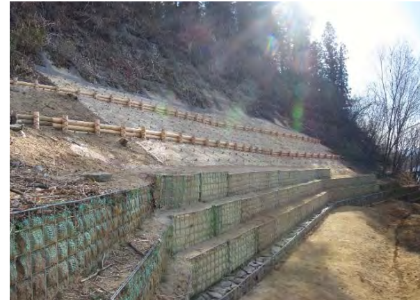
令和2年度完成 長根地区 山腹工
