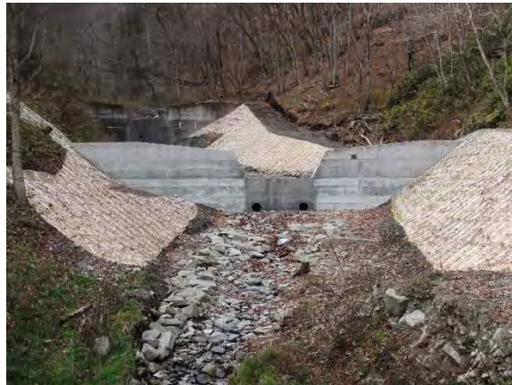
令和2年度完成 大家地区 治山ダム
