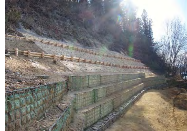
令和2年度完成 長根地区 山腹工
