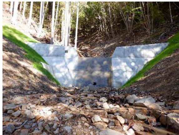
令和2年度完成 女遊戸地区 治山ダム
