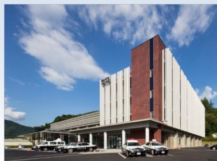
令和元年7月に運用を開始した釜石警察署、沿岸運転免許センター及び交通機動隊沿岸分駐隊の新庁舎
