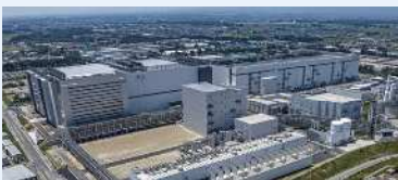
花巻PA近隣の製造業(キタ77岩手株第2製造棟)
