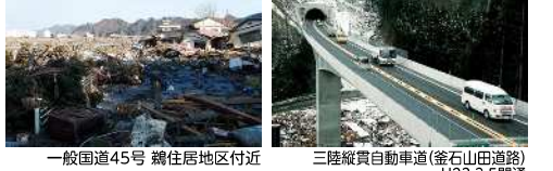
一般国道45号 鶉住居地区付近 三陸縦貫自動車道(釜石山田道路) H23.3.5開通 写真提供：三陸国道事務所
