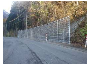
国道340号 浅内(岩泉町)
