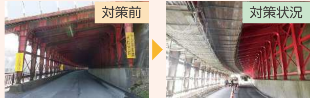
国道 107 号 大荒沢スノーシェッド (西和賀町)
