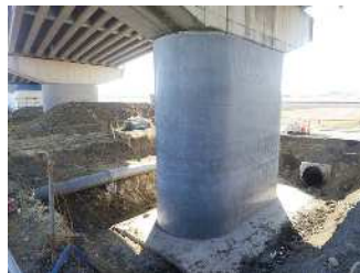
(主) 一関北上線 中里橋(一関市)
