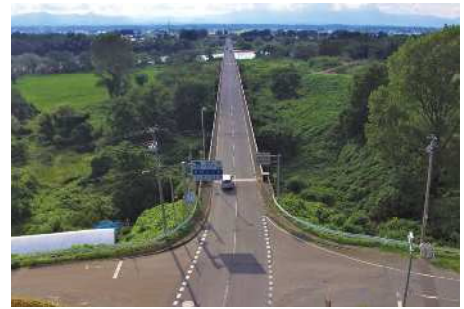
一般国道343号 藤橋 (昭和48年建設)
