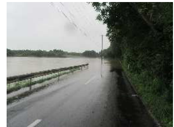
(主) 一関北上線 大久保~内堀(奥州市) 令和4年度事業化(冠水解消)
