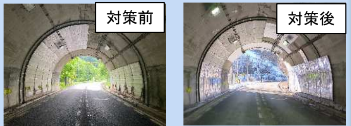
▲ (国) 106号 門馬トンネル (宮古市)
