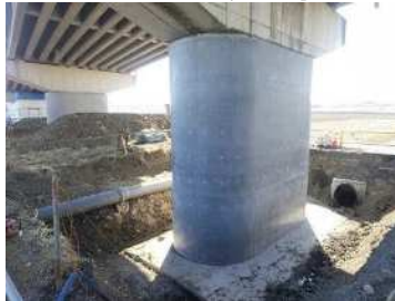
▲ (主) 一関北上線 「中里橋工区」(一関市)
