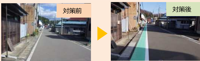
▲（主）岩手平舘線 城山工区（岩手町） カラーペイントによる歩行空間の確保（強調）
