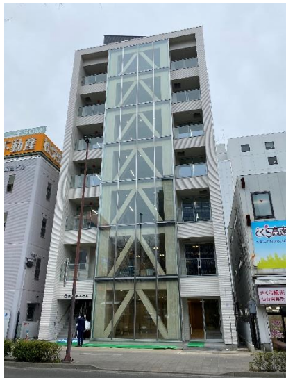
大型木造建築物（仙台市内）
