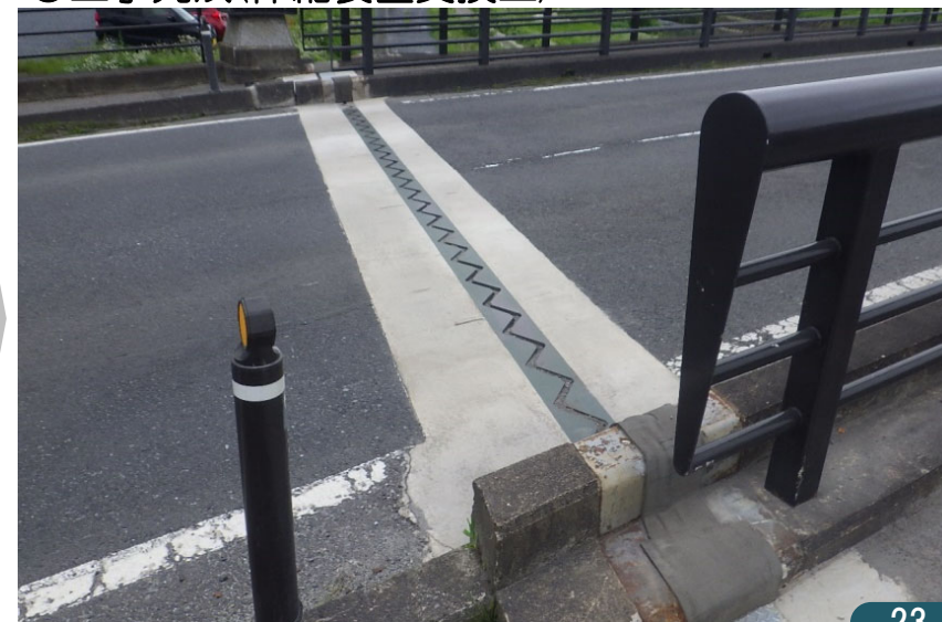
○工事完成(伸縮装置交換工)
