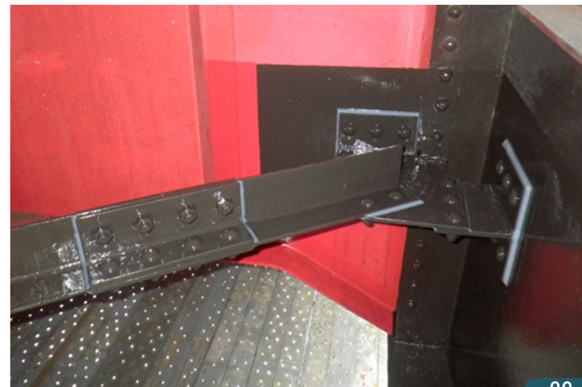
○工事完成(当て板補修工)
