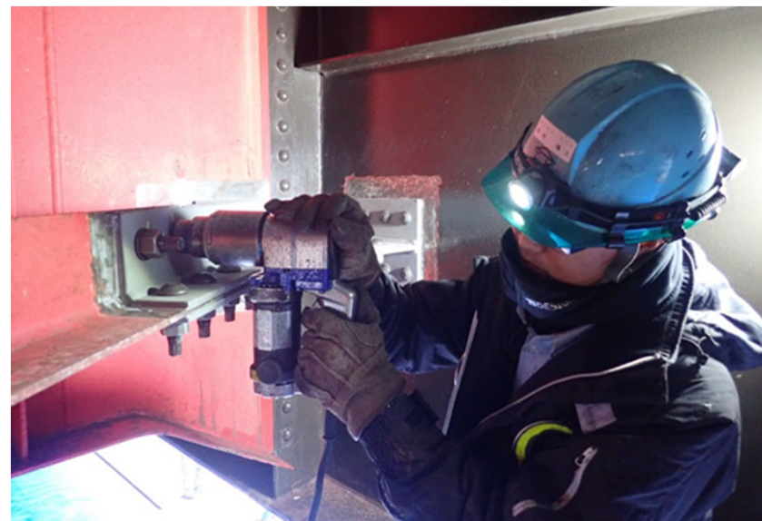
○工事完成(当て板補修工)
