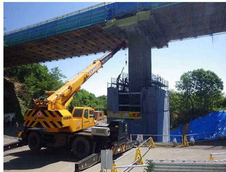
○工事完成(P1 橋脚巻立工)
