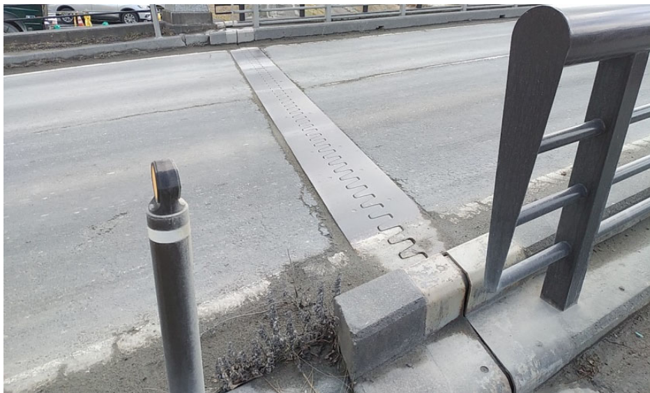
○工事着手前(伸縮装置交換工)
