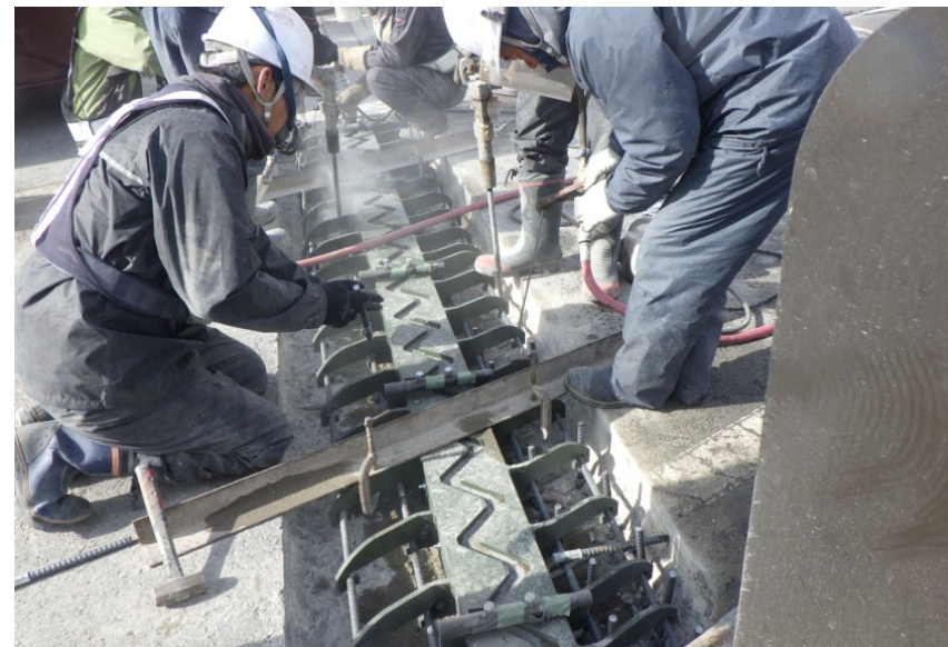
○工事完成(伸縮装置交換工)
