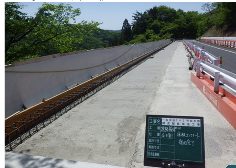
○工事完成(床版打換工)
