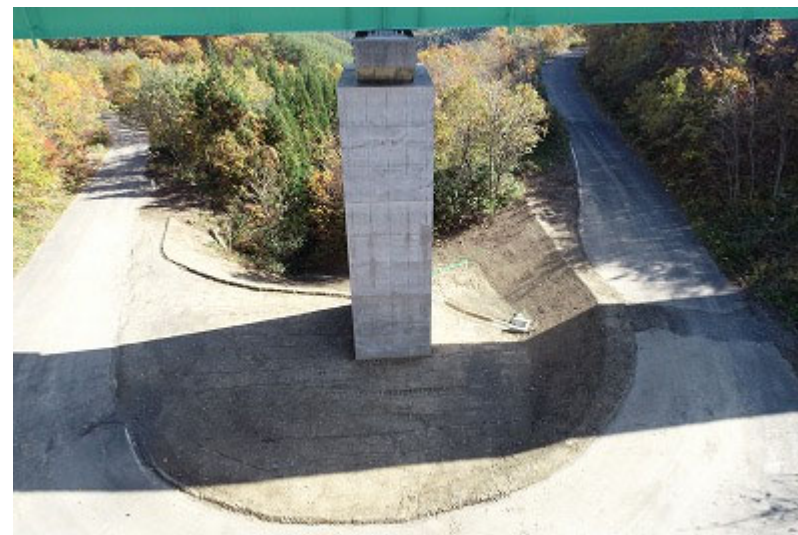
○工事完成(P1 橋脚巻立工)
