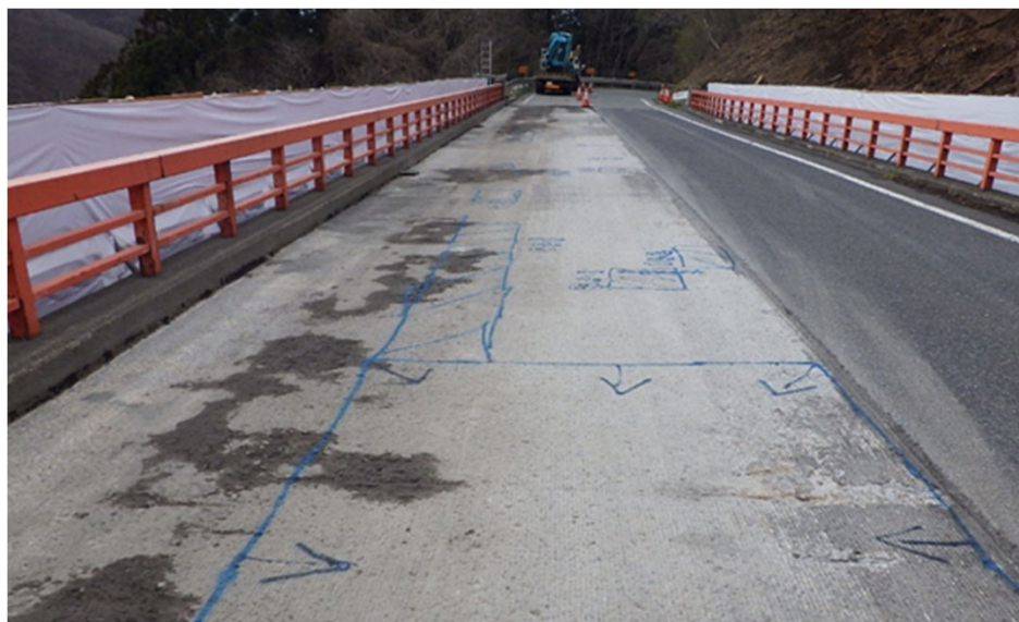
○工事着手前(床版打換工)
