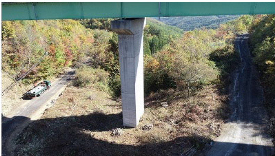
○工事着手前(P1 橋脚巻立工)
