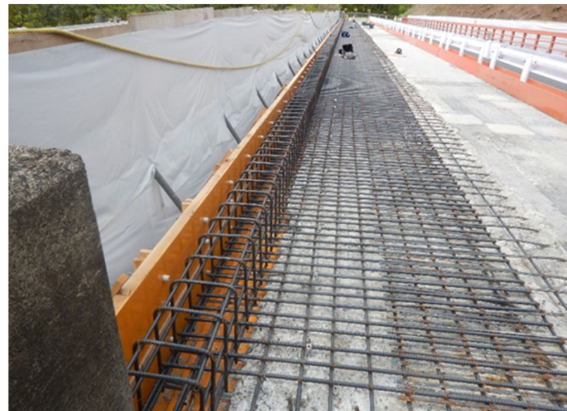
○工事完成(床版打換工)
