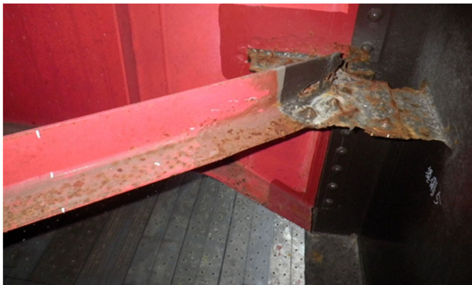
○工事着手前(当て板補修工)
