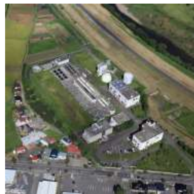
一関浄化センター
