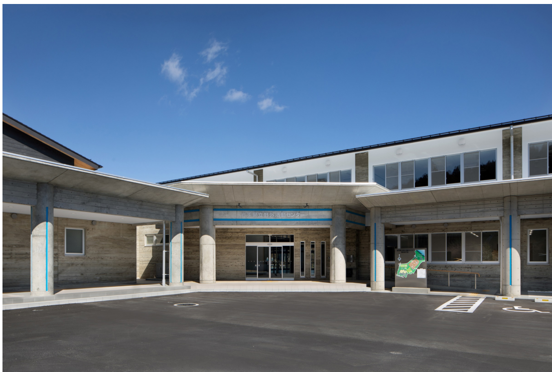
岩手県立野外活動センター災害復旧工事 令和3年3月完成
