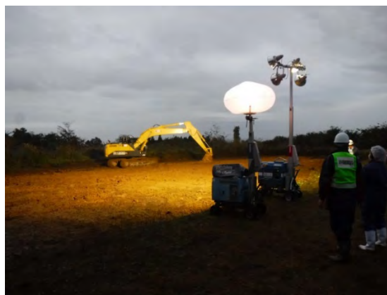
夜間の埋戻し作業（バックホウでの表面均し）
