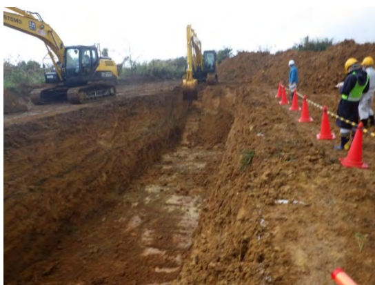
バックホウにて埋却溝を掘削（作業は階段状の溝堀）
