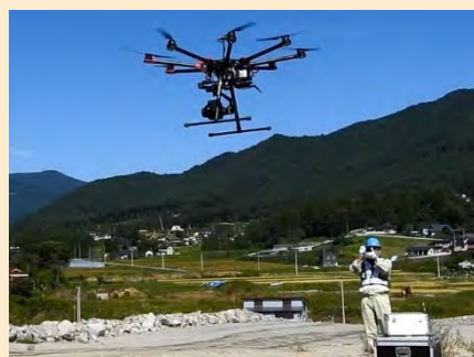
写真2：UAV(ドローン)による3次元測量
