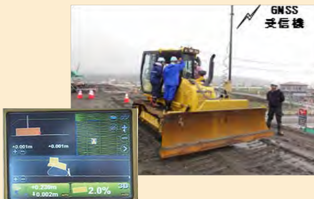
写真1：マシンコントロールシステムによる施工
