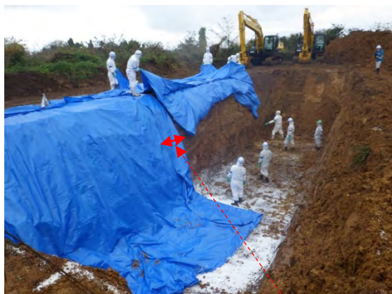
ブルーシート敷設（今年度は延長方向の重ねせを1mとして実施）
