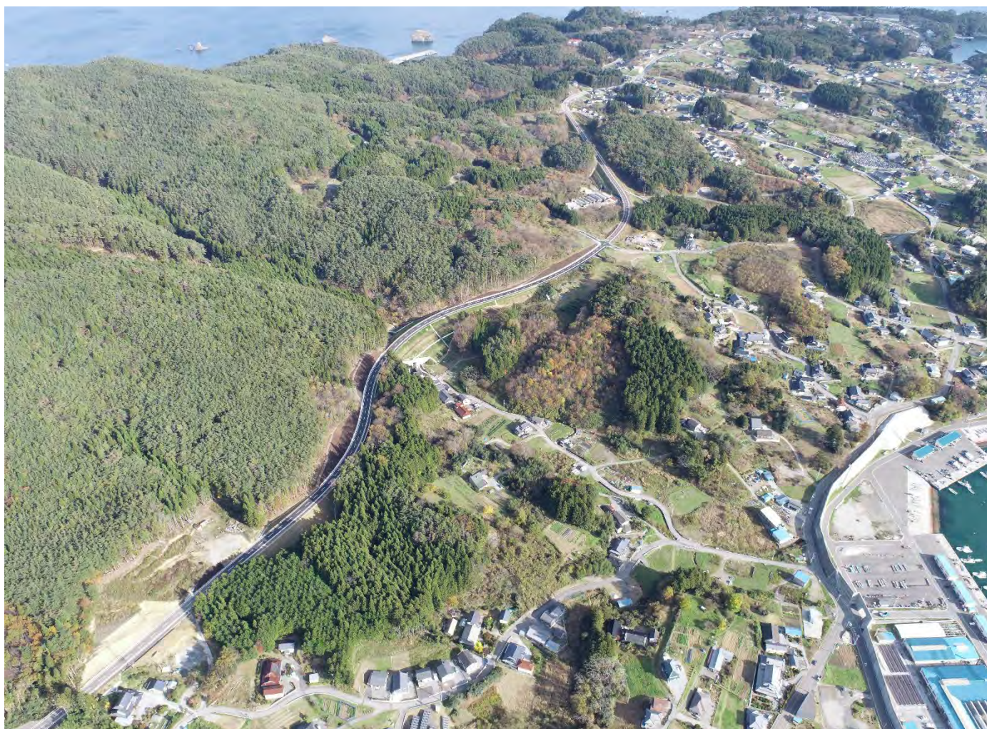
開通直前の様子（R3.11.16撮影）
