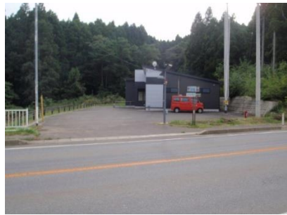
造成後（屯所・舗装等は別事業で整備）
