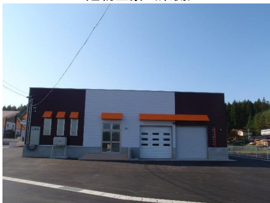
建物全景（東側）
