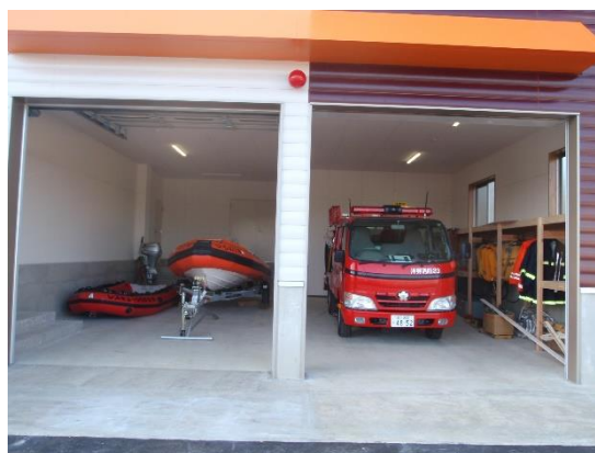
建物内部（消防団車庫）
