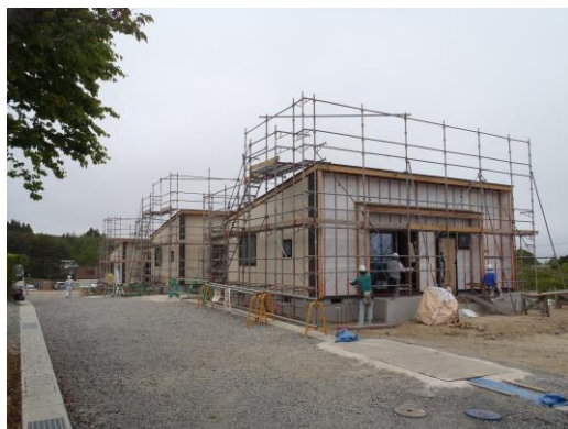
説明：建設工事中の用地の様子 3 （用地の南側から撮影）
