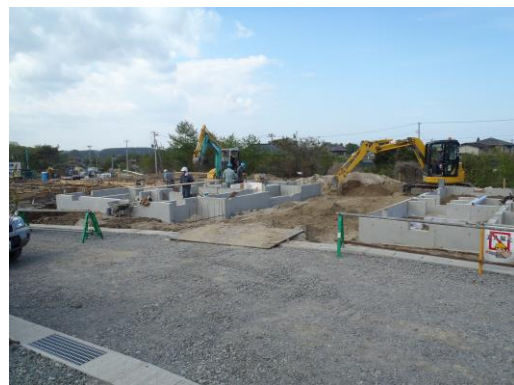
説明：建設工事中の用地の様子 2 （用地の南西側から撮影）
