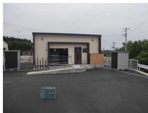
説明：舗装工事完了後の用地の様子 （用地の南側から撮影）
