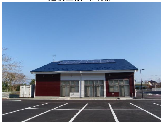
建物全景（西側）
