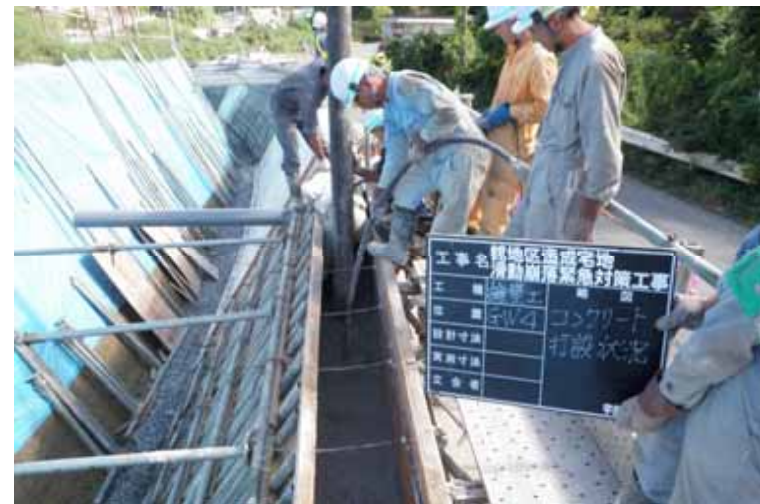
コンクリート打設状況
