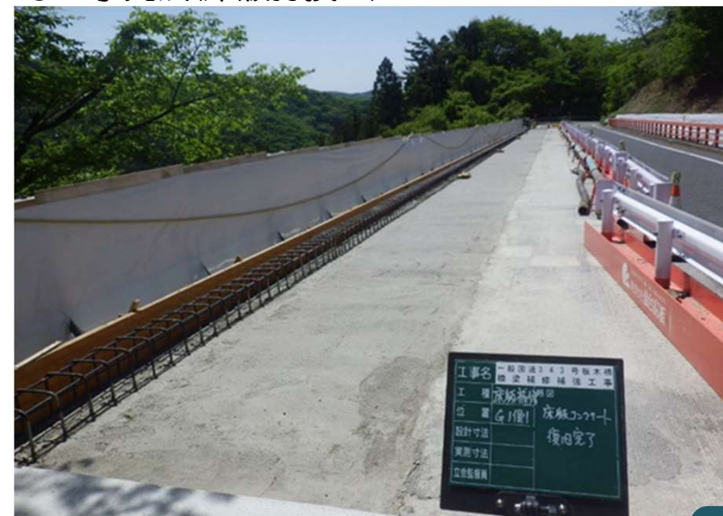
○工事完成(床版打換工)
