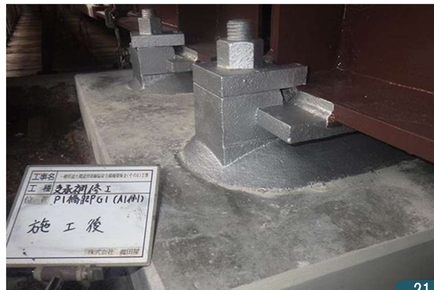
○工事完成(支承補修工)
