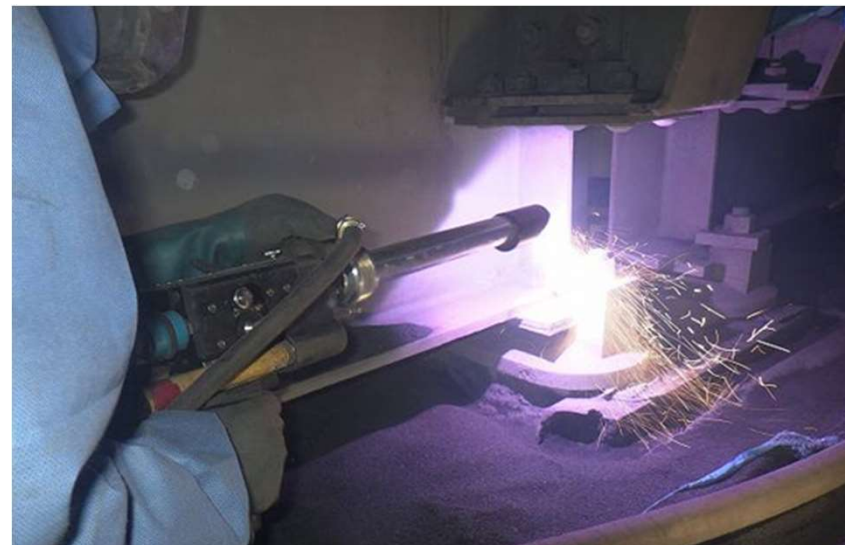
○工事状況(支承補修工)
