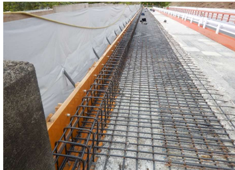
○工事完成(床版打換工)
