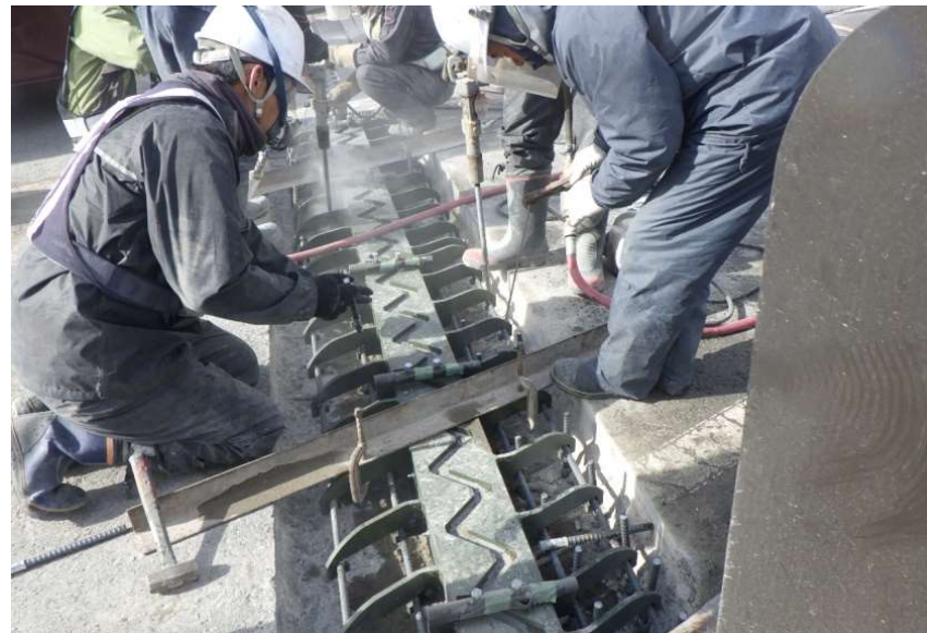
○工事完成(伸縮装置交換工)
