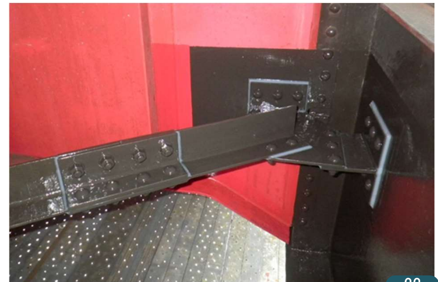
○工事完成(当て板補修工)
