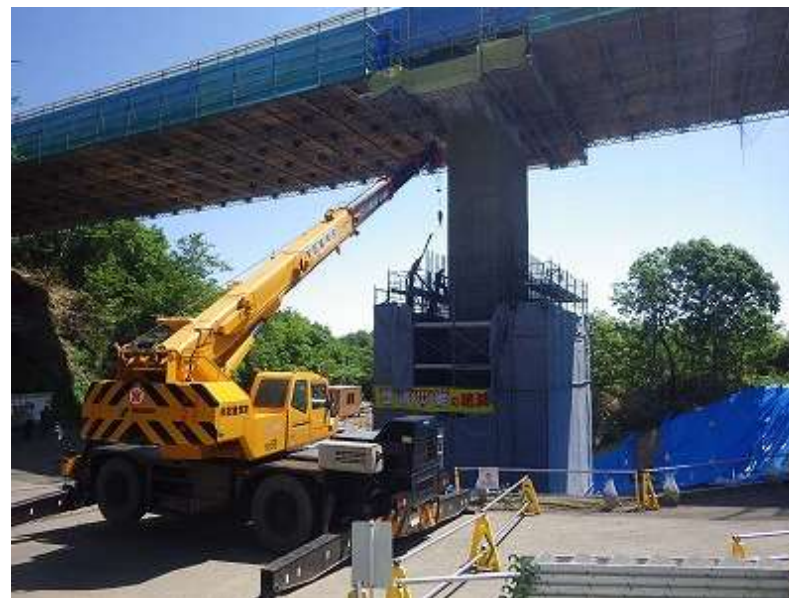
○工事完成(P1 橋脚巻立工)
