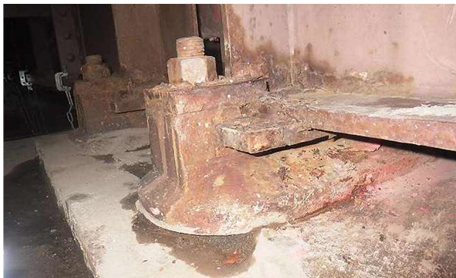
○工事着手前(支承補修工)
