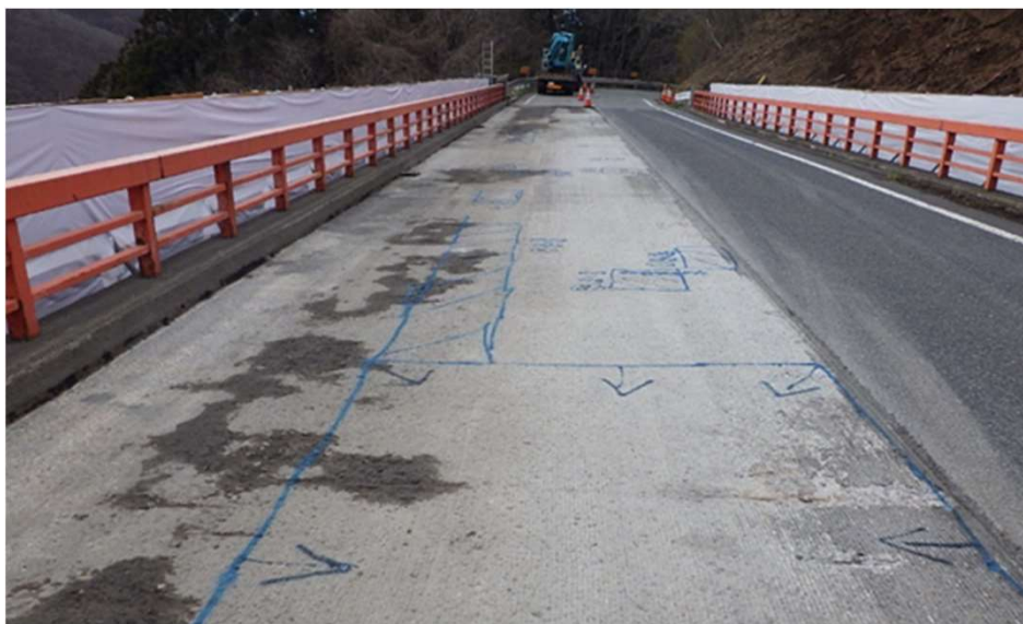
○工事着手前(床版打換工)
