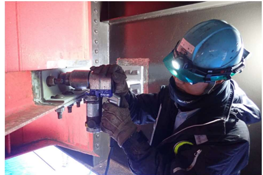
○工事完成(当て板補修工)
