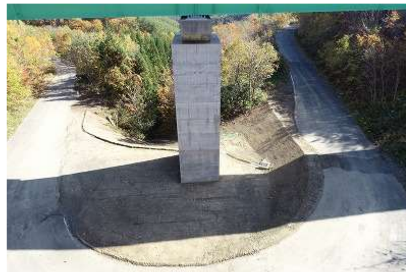
○工事完成(P1 橋脚巻立工)
