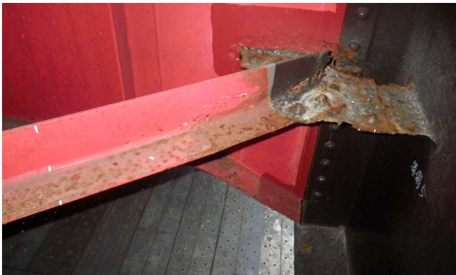
○工事着手前(当て板補修工)
