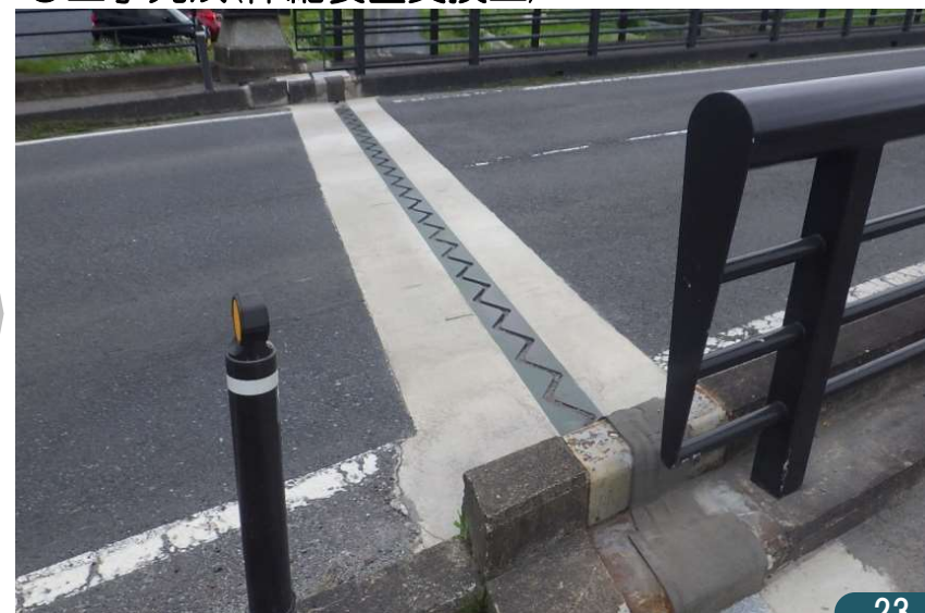
○工事完成(伸縮装置交換工)
