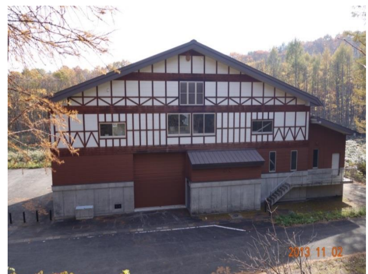
⑬ 柏台発電所
