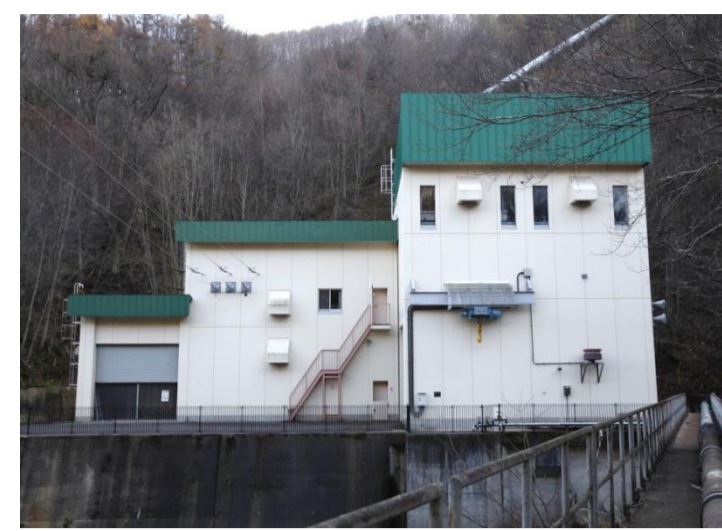
⑧ 北ノ又発電所
