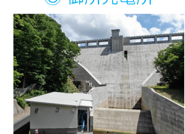
⑯ 築川発電所
