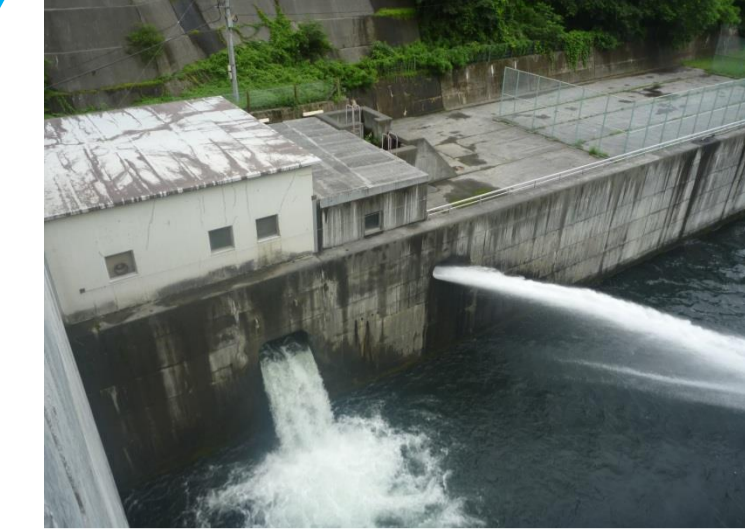
⑦ 滝発電所
