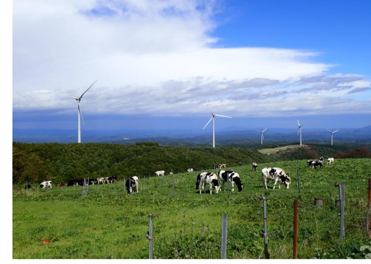
2 高森高原風力発電所
