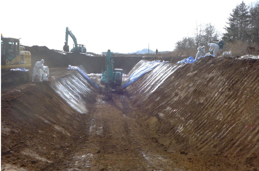
埋却溝の掘削及び石灰散布
