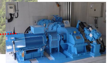
【余剰水圧利用型クロスフロー水車】
