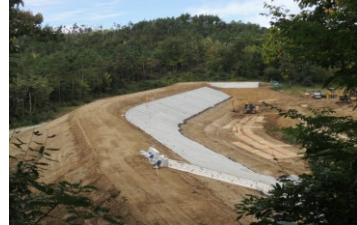
【ため池の対策工事状況】
