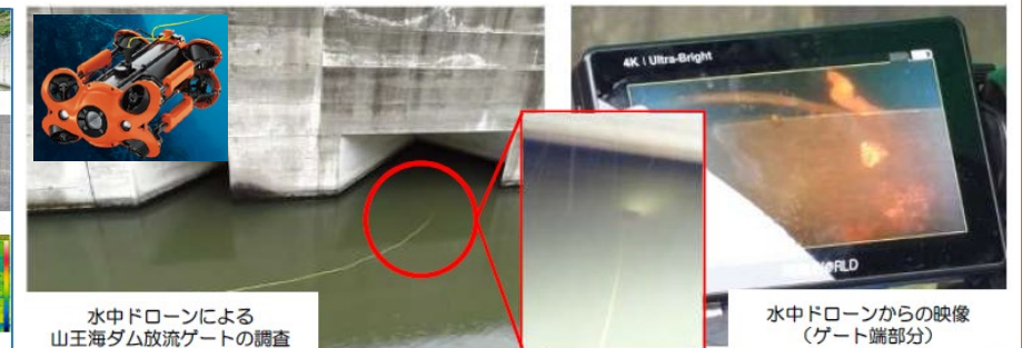
【水中ドローンを活用した施設点検】
