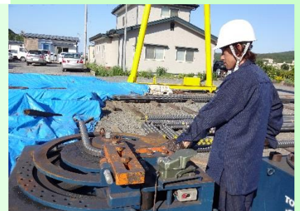
▲ 鉄筋の曲げ加工
