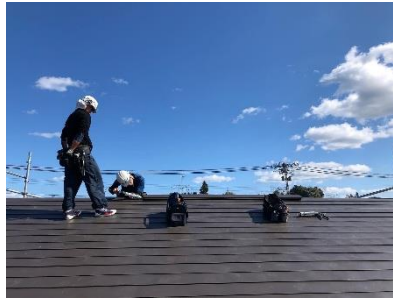
▲ 屋根の施工中
