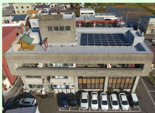
宮城建設株式会社 外観
