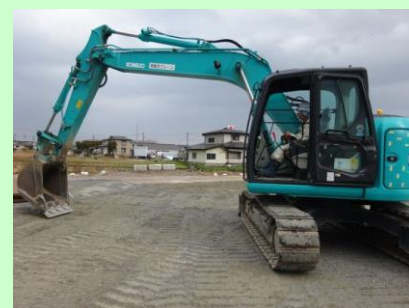
▲ 現場作業の様子
