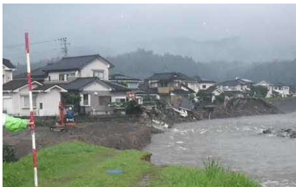
河岸侵食による家屋の倒壊(花月川)
