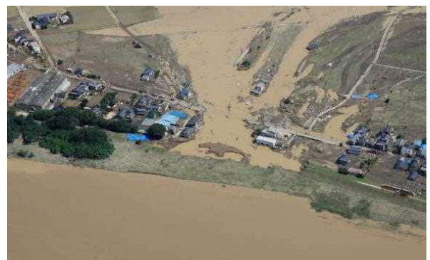
堤防決壊による家屋の流失(鬼怒川)
